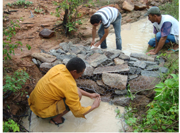
Figura 03: Construção de uma barragem de contenção de sedimentos.
